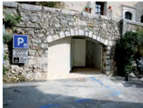
Juste avant d'arriver sur la place Capel, des WC publics ont été aménagés pour les personnes à mobilité réduite.
