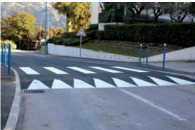
Plateau traversant pour sécuriser la traversée des piétons devant l'école des Rosemarines.
