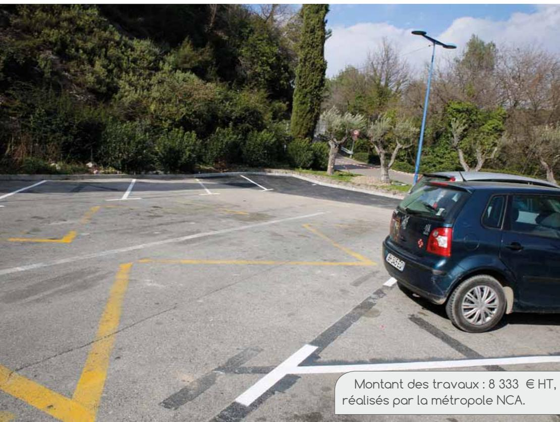
Autre chantier mené sur la commune au mois de mars : l'extension du parking situé derrière l'école Marcel Pagnol, à proximité immédiate de l'intersection avec la route de la Ginestière. Outre des travaux de terrassement, la mise en œuvre de bordures et une reprise partielle des enrobés, quatre nouvelles places ont été créées et matérialisées au sol. ■
