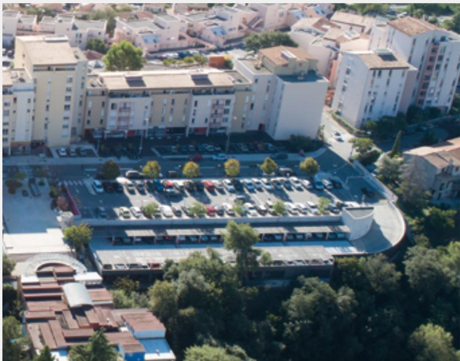
Le projet consiste à reprendre structurellement les capacités de charge des piliers du parking actuel pour permettre de porter une nouvelle dalle béton dans le prolongement du niveau 0 tel qu'il existe aujourd'hui. Grâce à ce prolongement de dalle, la capacité du parking du forum Jacques Prévert connaîtra un gain de **40 places** ! ■
