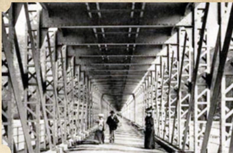
La Compagnie des Chemins de Fer du Sud de la France optera donc pour un pont-cage à treillis métallique inventé aux États-Unis et à la demande de l'Armée. Ce dernier sera à double-tablier : la voie ferrée au-dessus, la route au-dessous. Le chantier débute en juin 1889. Terminé en juillet 1890, le pont de la Manda est ouvert à la circulation routière le mois qui suit.
